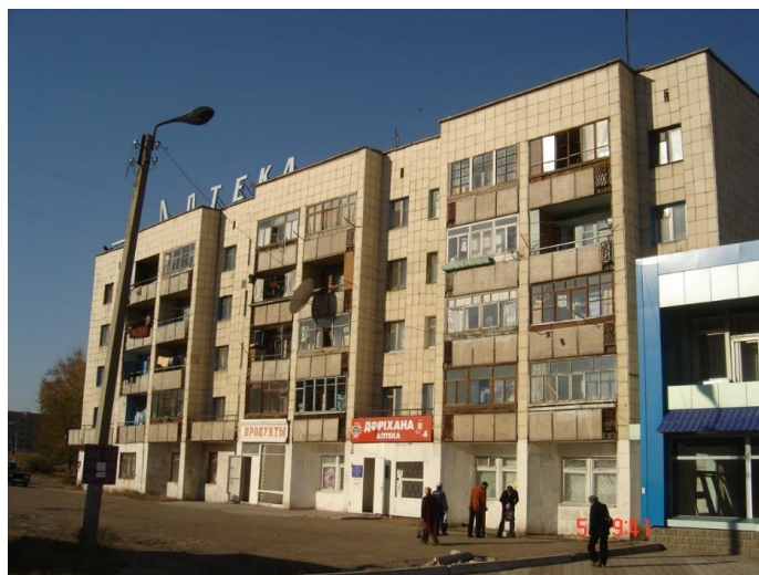
Рисунок 2. Общий вид жилого дома
