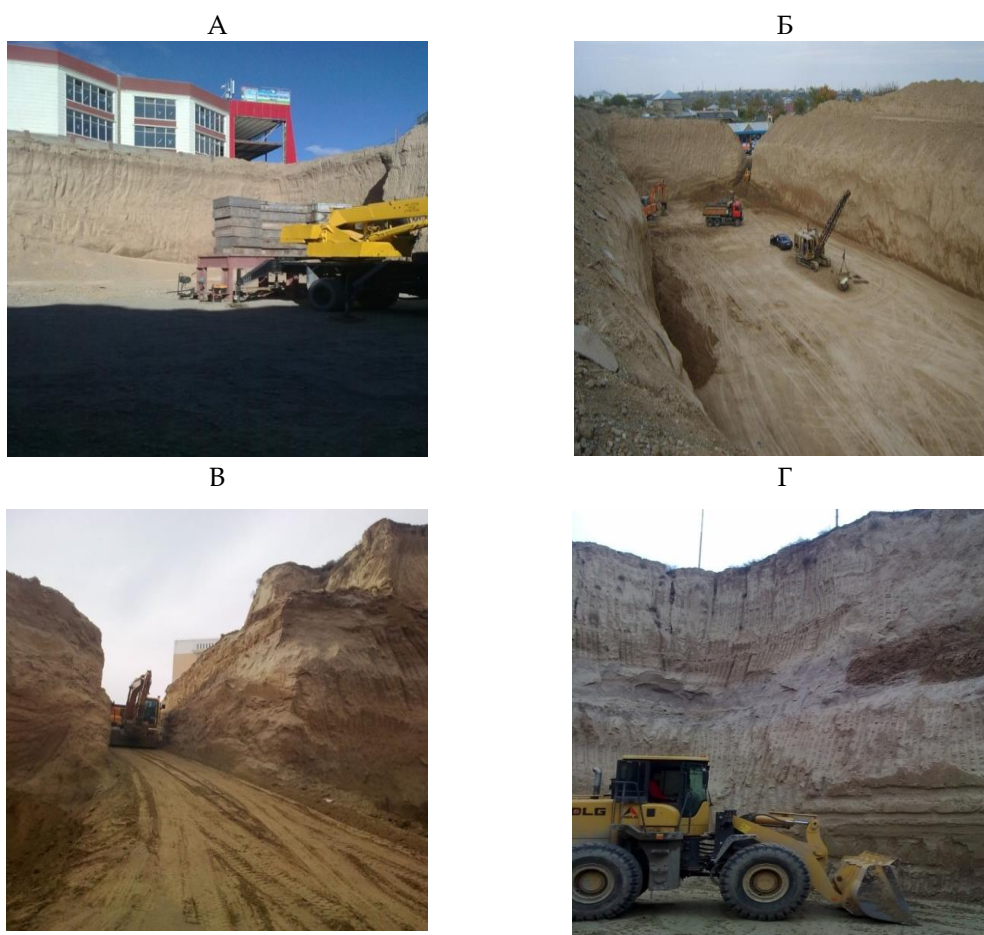
Рисунок 7. А – пример устройства котлована вблизи существующего здания с вертикальным устройством откосов; Б – котлован с выполаженными откосами под 16-этажное здание; В, Г – котлован с вскрытым слоем супеси Примечание – фото автора (Бровко И.С., 2024)
