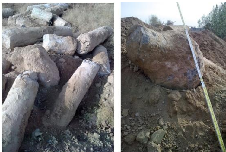
Рисунок 2. Фрагменты свай, демонтированные при устройстве нового котлована
