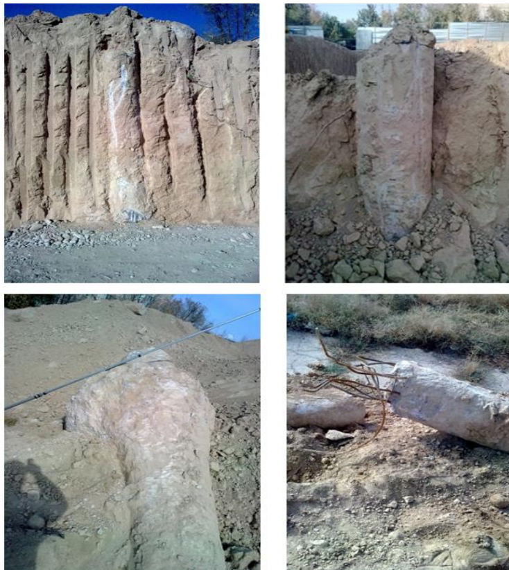
Рисунок 1. Оголенные (верхний ряд) и извлеченные (нижний ряд) конструкции буронабивных свай
