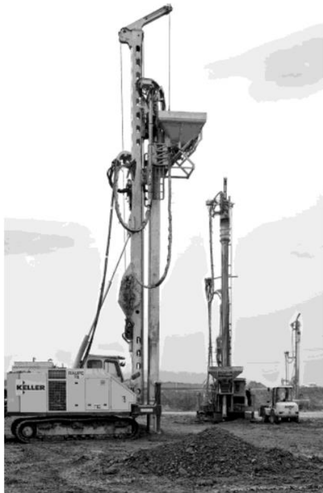
Рисунок 6. Виброкат с вибратором с нижней подачей
