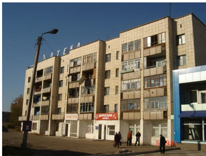
Рисунок 2. Общий вид жилого дома
