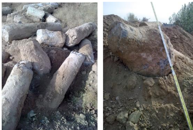
Рисунок 2. Фрагменты свай, демонтированные при устройстве нового котлована
